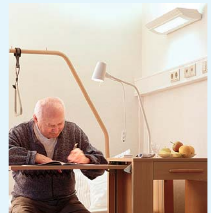
1 Zusätzliche Beleuchtungskomponenten schaffen effizient individuelles Licht zum Lesen mit erhöhter Beleuchtungsstärke
